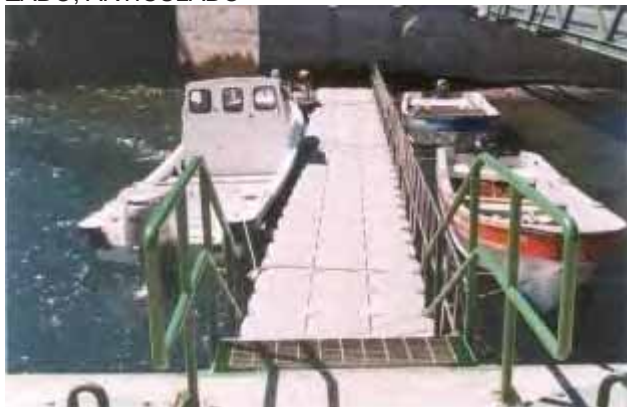
FIGURA 92 – TRAPICHE / ANCORADOURO COM NÍVEL ALTO DAS ÁGUAS
