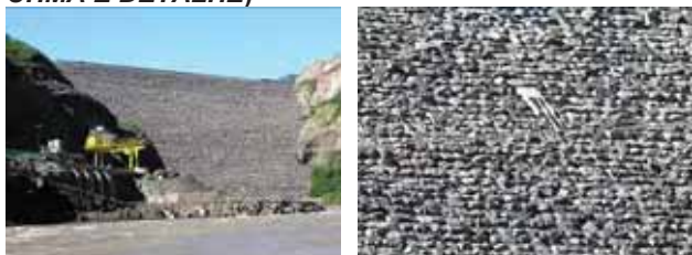
FOTO 13 – PONTO 1 (VISTA DO RESERVATÓRIO DA UHMA E DETALHE)
