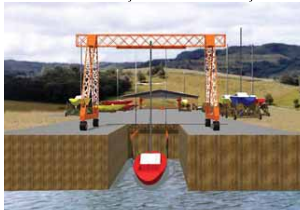
FIGURA 100 – VISTA DA DOCA MOLHADA E DO PÓRTICO COM EMBARCAÇÃO PRONTA PARA IÇAMENTO
