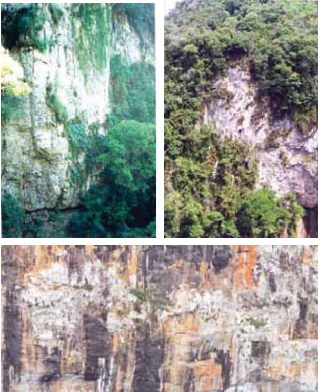
FOTO 32 – OS PAREDÕES VERTICALIZADOS PROVENIENTES DE DERRAMES ÁCIDOS
