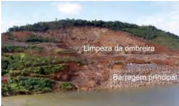
FOTO 23 – OBRAS DA BARRAGEM PRINCIPAL
