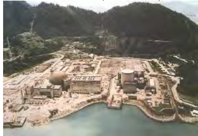
FOTO 4 – USINA NUCLEAR (ANGRA I, II E III)
