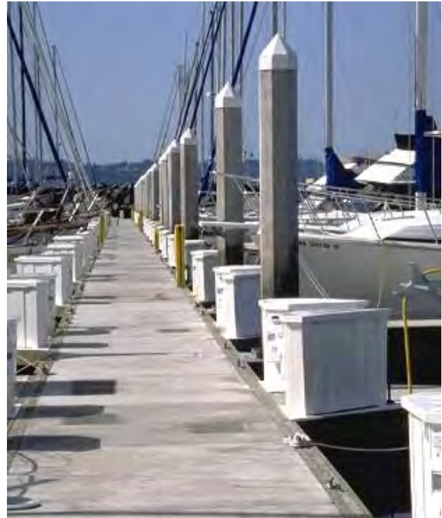
FIGURA 48: DOCAS FLUTUANTES DE CONCRETO
