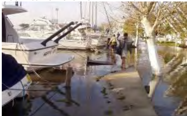
FIGURA 39: ESTRUTURAS MAL PLANEJADAS
