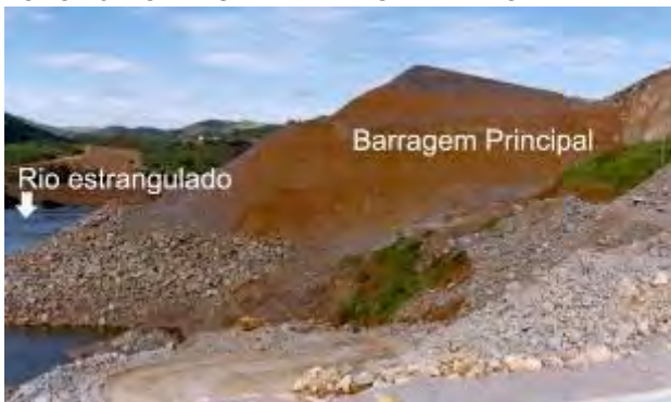
FOTO 24 –EMBOQUE DOS TÚNEIS (M. DIREITA)
