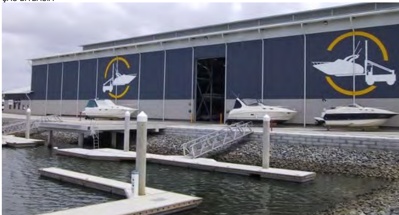
FIGURA 52: ESTRUTURAS E CONTENÇÕES: ESTRUTURA METÁLICA NO GALPÃO E “DRystack”; ESTACAS DE CONCRETO NAS DOCAS FLUTUANTES; TALUDE PROTEGIDO POR PEDRAS DE MÃO (RIP-RAP) NA CONTENÇÃO DA BACIA
