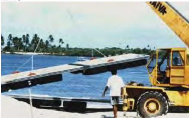
FIGURA 50: INSTALAÇÃO DE FLUTUANTES DE ALUMÍNIO
