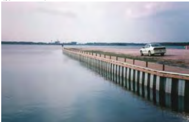
FIGURA 51: EXEMPLO DE CONTENÇÃO POR ESTAQUEAMENTO
