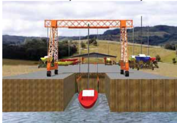
FIGURA 23: VISTA DA DOCA MOLHADA E DO PÓRTICO COM EMBARCAÇÃO PRONTA PARA IÇAMENTO
